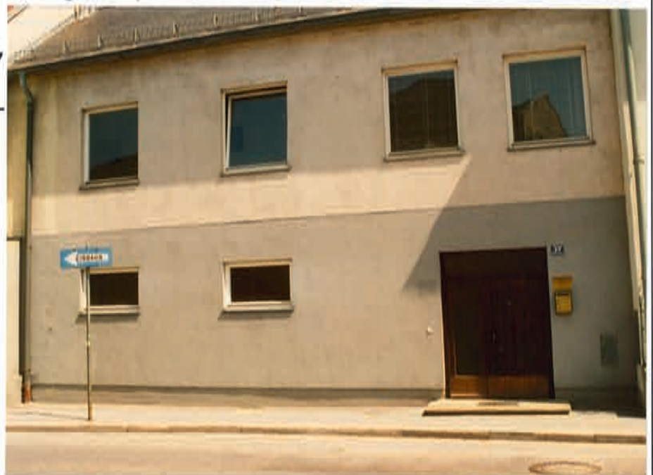
▲ Das Haus Kirchengasse 37 vor der Fassadengestaltung 1992 ▲
